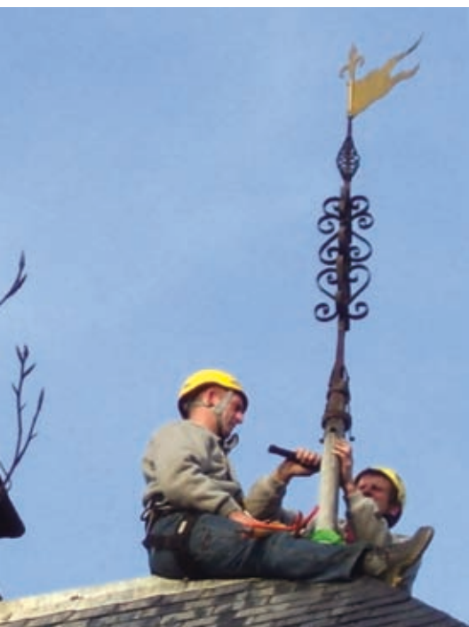
Werkzaamheden aan de bekroning
