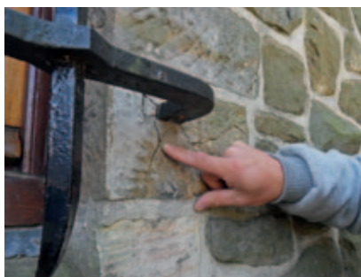
Roestdruk laat stenen barsten
